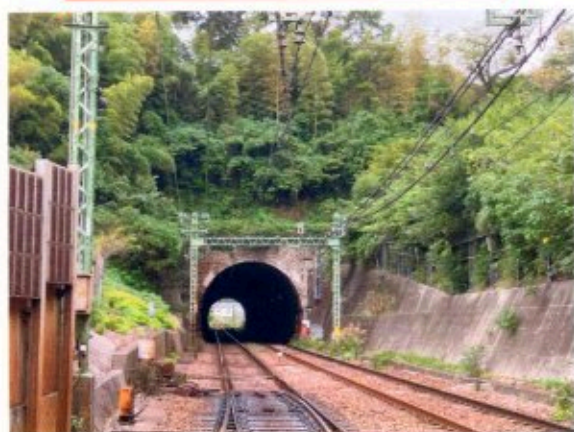
現在状況 トンネル坑口付近
